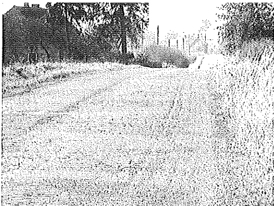
Droga nr 0026Z – zarośnięte pobocze, nierówna krawędź jezdni. Nawierzchnia w złym stanie, licznie spękania nawierzchni.
