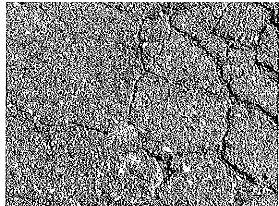
Droga nr 0026Z – zarośnięte pobocze, nierówna krawędź jezdni. Nawierzchnia w złym stanie, licznie spękania nawierzchni.
