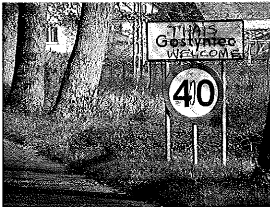
Droga nr 0031Z m. Gostyniec – nie wymieniono białej tablicy miejscowości pomimo wskazania w poprzednim protokole, tablica miejscowości oraz znak B-33 zdewastowane i schowane za drzewami.
