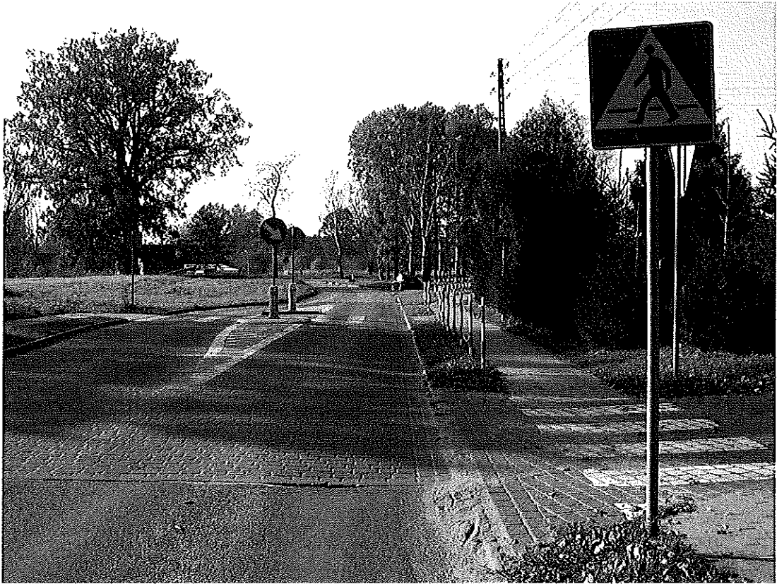
Droga nr 0031Z m. Gostyniec – znak A-6 na pierwszym planie – lico znaku skierowane w niewłaściwą stronę.
