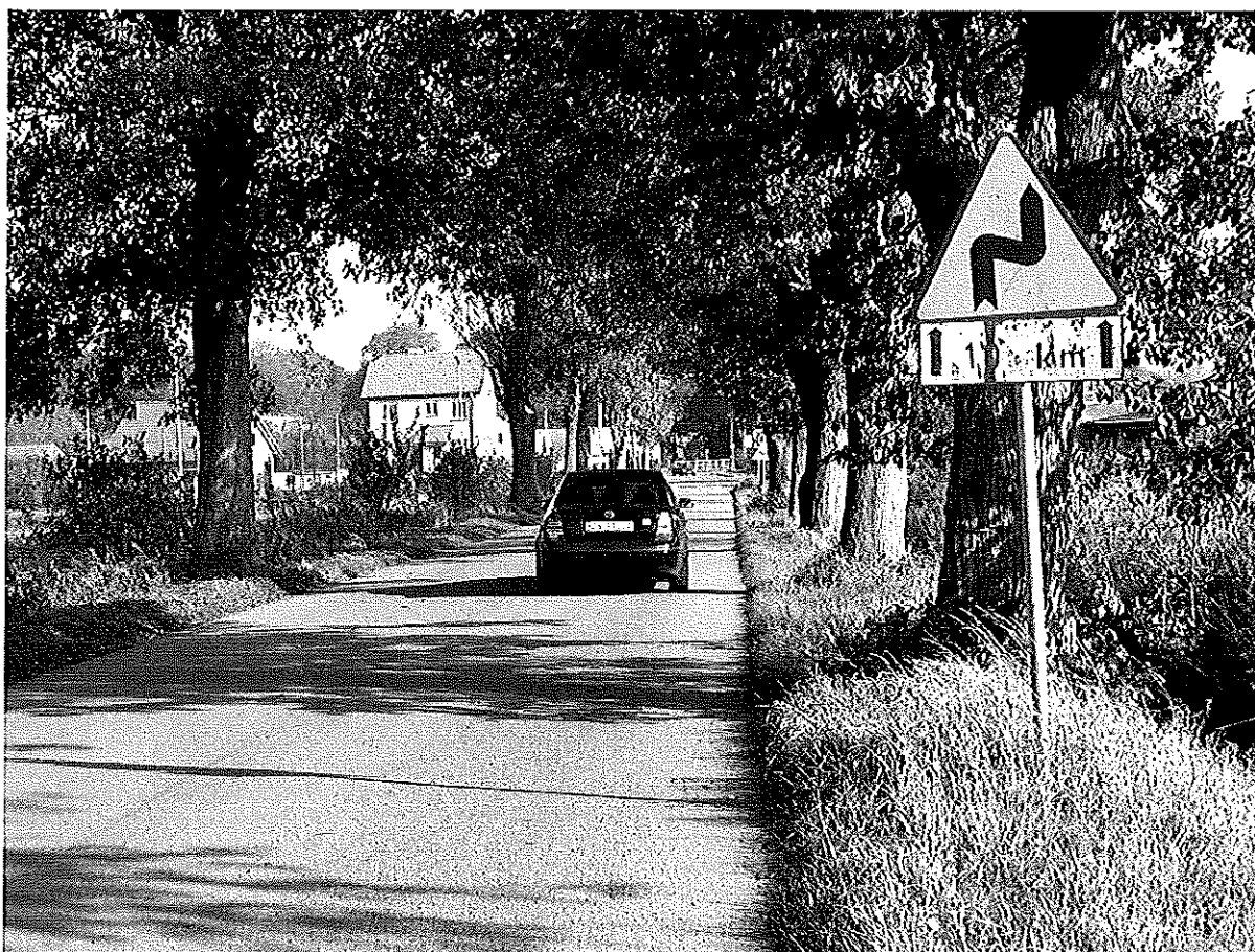
Droga nr 0100Z przed m. Gostyń – tabliczka T-2 do wymiany, stan tabliczki widoczny również na zdjęciu zamieszczonym w protokole z kontroli problemowej
