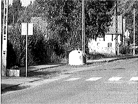
Droga nr 0026Z m. Chomino – brak oznakowania przystanków znakami D-15. Zalegający piasek na drodze wzdłuż krawężników. Zastosowano linię przystankową P-17 oraz linię P-14 przed przejściem dla pieszych.
