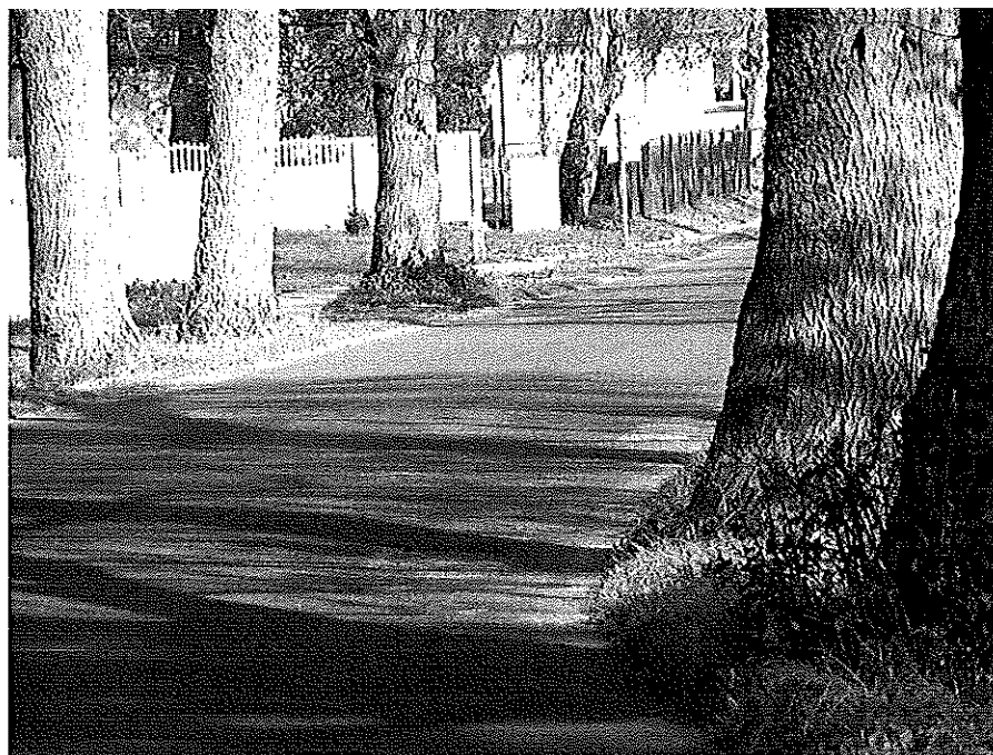
Droga nr 0031Z – nieoznakowane drzewo w skrajni drogi.
