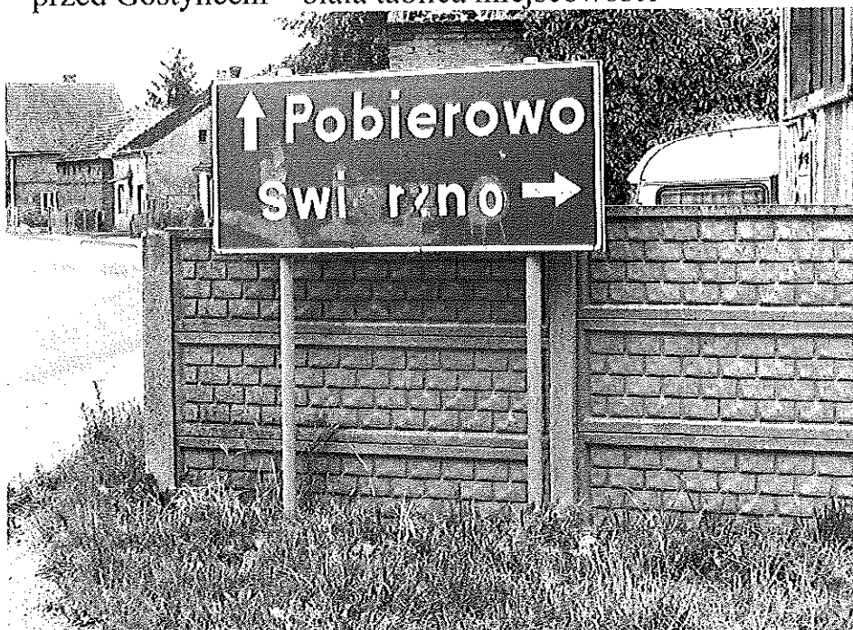
0031 Z Gostyń na Świerzno – tablica E-2a (niewłaściwie osadzona, nieczytelna)
