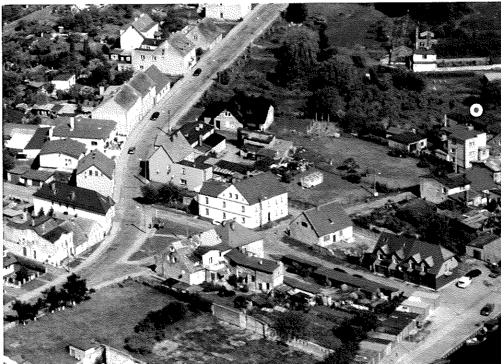
Zabudowania położone w sąsiedztwie terenu planowanej inwestycji.
