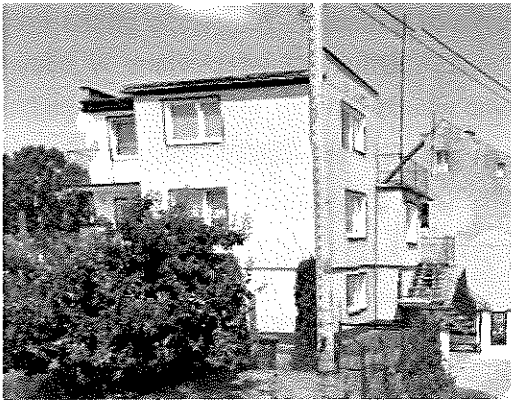
Budynek mieszkalny jednorodzinny na terenie działki nr 113.
