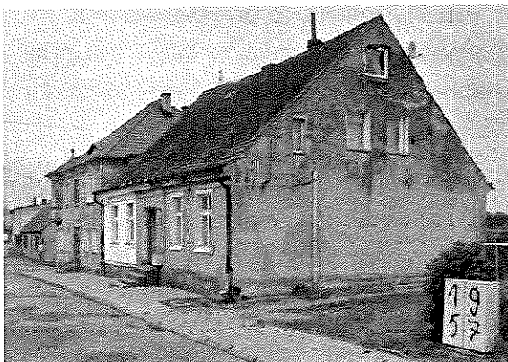
Budynek mieszkalny wielorodzinny na terenie działki nr 266/2 oraz wielorodzinny [na drugim planie] na terenie działki nr 265.
