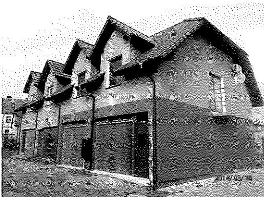
Budynek garażowy na terenie działek nr 124/6 do 124/9.
