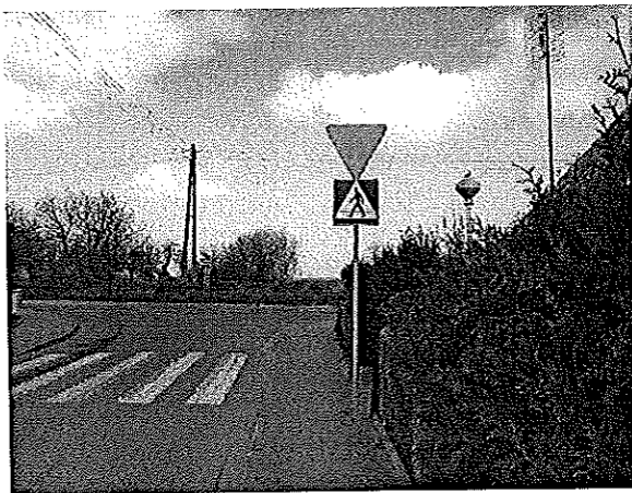
Skrzyżowanie drogi powiatowej nr 1024Z z drogą powiatową nr 1023Z – m. Gostyń. Znak pionowy A-7 bez wyraźnej czerwonej obwódki umieszczony na wspólnej konstrukcji wsporczej co znak informacyjny D-6. Brak odpowiedniej tabliczki T-6 pod znakiem A-7. Brak linii warunkowego zatrzymania P-14 przed przejściem dla pieszych. Wyblakła tabliczka T-6 pod znakiem D-1.
