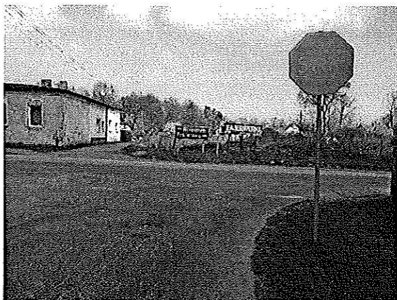
Skrzyżowanie drogi powiatowej nr 1024Z z drogą powiatową nr 1031Z – m. Gostyń. Znak B-20 wyblakły/zniszczony. Brak linii bezwzględnego zatrzymania (P-12). Brak odpowiedniej tabliczki T-6 pod znakiem pionowym B-20.
