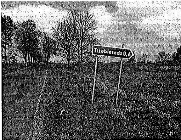
Skrzyżowanie drogi powiatowej nr 1031Z z drogą powiatową nr 1023Z. Znak E-4 zniszczony – znak kierunku miejscowości znajduje się tylko z jednej strony drogowskazu.
