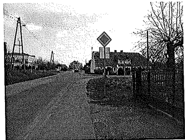
Skrzyżowanie drogi powiatowej nr 1024Z z drogą powiatową nr 1023Z – m. Gostyń. Znak pionowy A-7 bez wyraźnej czerwonej obwódki umieszczony na wspólnej konstrukcji wsporczej co znak informacyjny D-6. Brak odpowiedniej tabliczki T-6 pod znakiem A-7. Brak linii warunkowego zatrzymania P-14 przed przejściem dla pieszych. Wyblakła tabliczka T-6 pod znakiem D-1.
