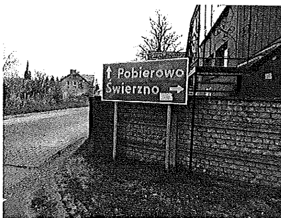
Skrzyżowanie drogi powiatowej nr 1024Z z drogą powiatową nr 1031Z – m. Gostyń. Znaki drogowskazowe E-2a zabrudzone. Wygięta podpora wsporcza znaku widocznego po lewej stronie.
