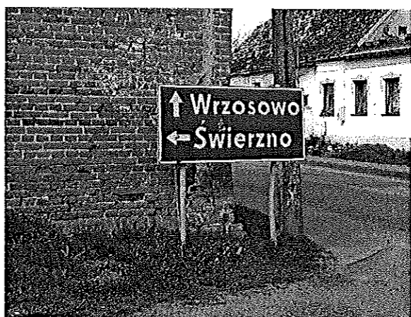
Skrzyżowanie drogi powiatowej nr 1024Z z drogą powiatową nr 1031Z – m. Gostyń. Znaki drogowskazowe E-2a zabrudzone. Wygięta podpora wsporcza znaku widocznego po lewej stronie.
