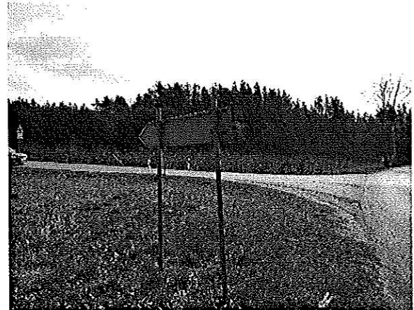
Skrzyżowanie drogi powiatowej nr 1031Z z drogą powiatową nr 1023Z. Znak E-4 zniszczony – znak kierunku miejscowości znajduje się tylko z jednej strony drogowskazu.
