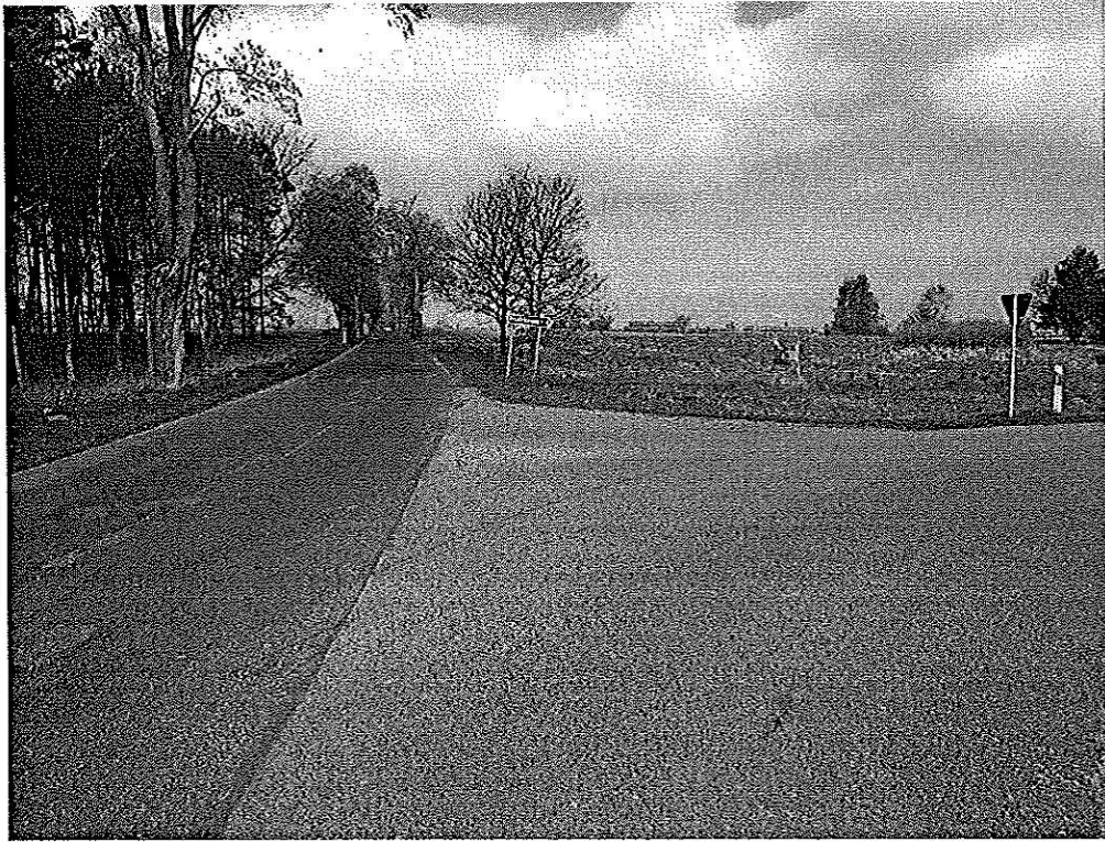
Skrzyżowanie drogi powiatowej nr 1031Z z drogą powiatową nr 1023Z. Brak oznakowania poziomego skrzyżowania jako miejsca szczególnie niebezpiecznego.
