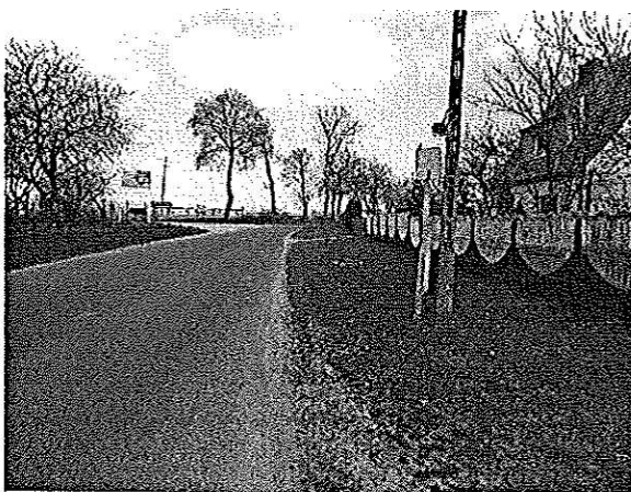
Droga nr 0031Z w m. Gostyń. Oznakowanie przystanku autobusowego w dalszym ciągu nie wymienione. Brak zatoki autobusowej lub oznakowania poziomego przystanku (P-17).
